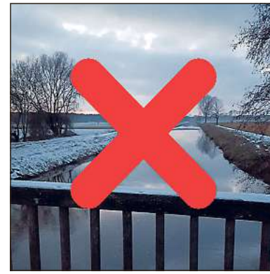
Drei Brückenerneuerungen standen im Haushalt. Die Maßnahmen sollen verschoben werden.
